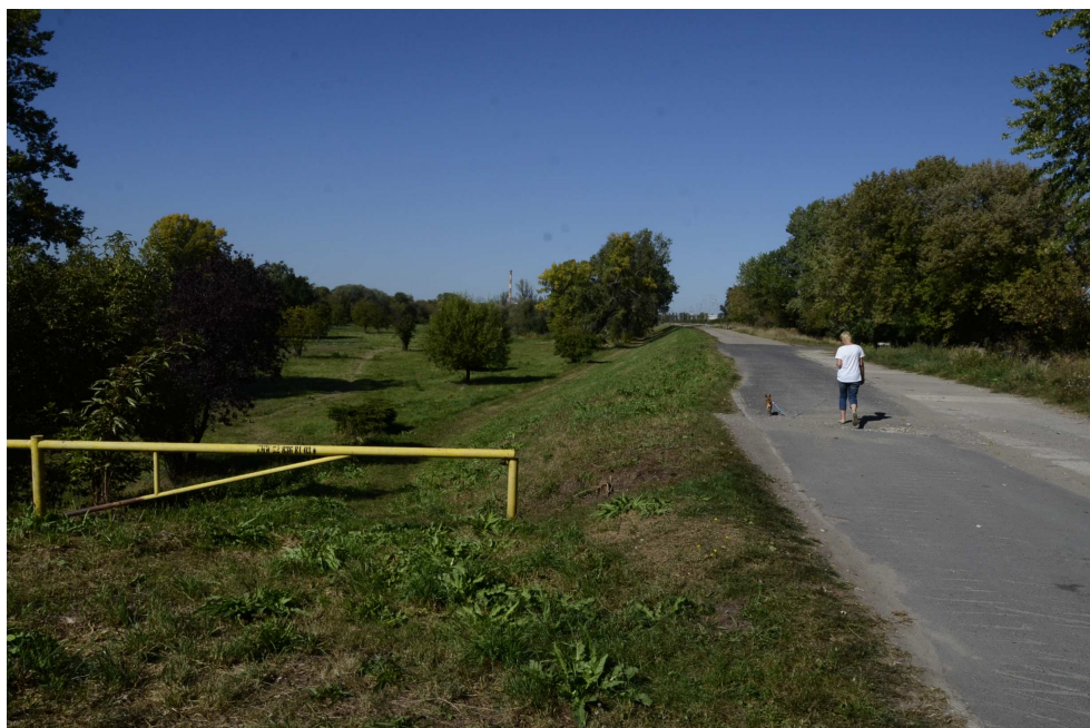
Fot. 2 km 0+312 wjazd międzywale widok w dół rzeki
