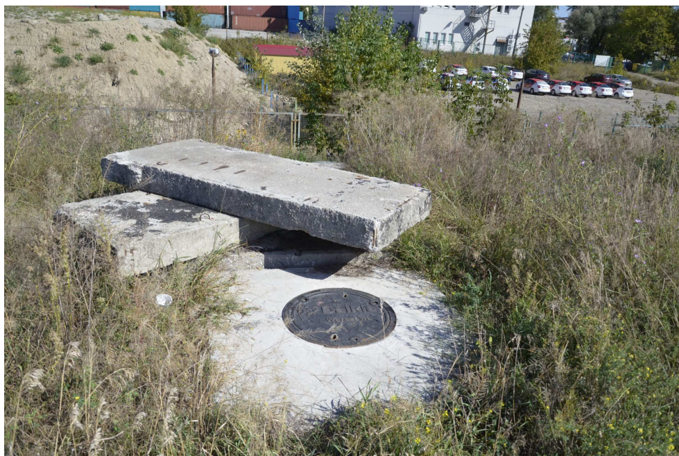
Fot. 8 km 1+818 Komora w korpusie wału
