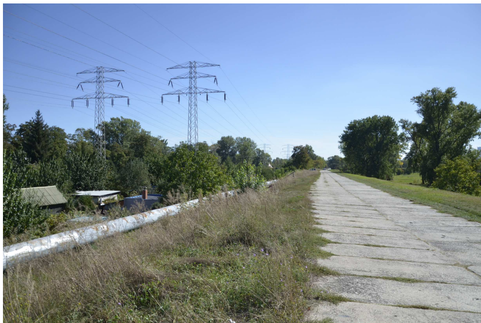
Fot. 5 km 0+810 widok korony i odpowietrznej skarpy wału
