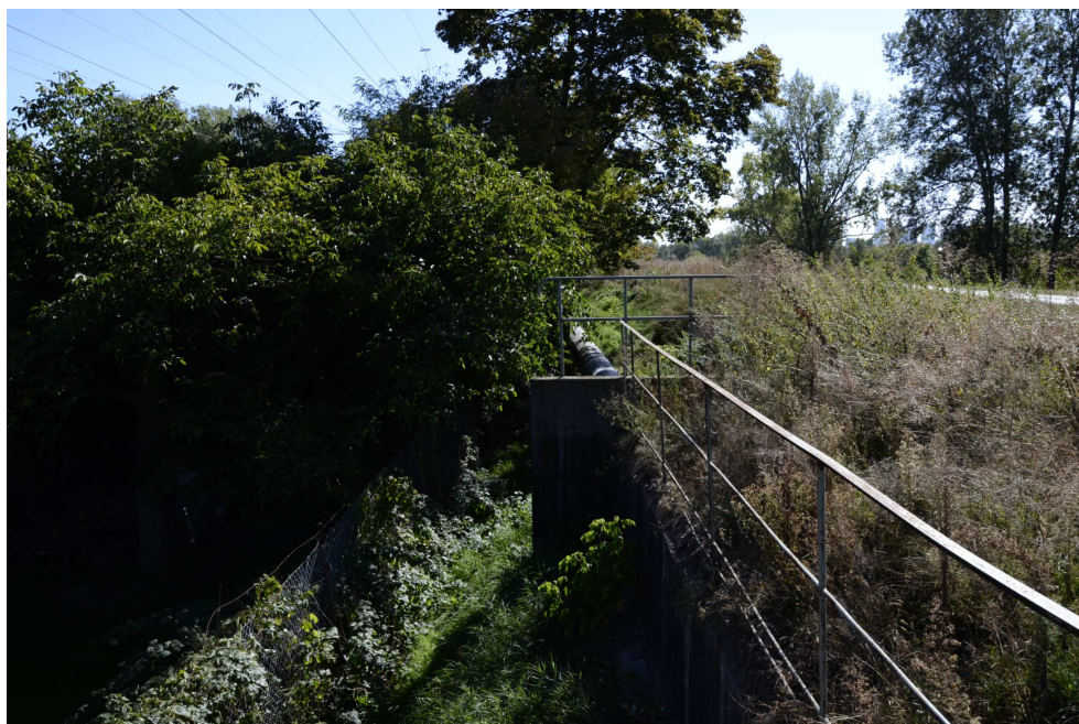
Fot. 4 km 0+600 rurociąg wzdłuż odpowietrznej skarpy wału
