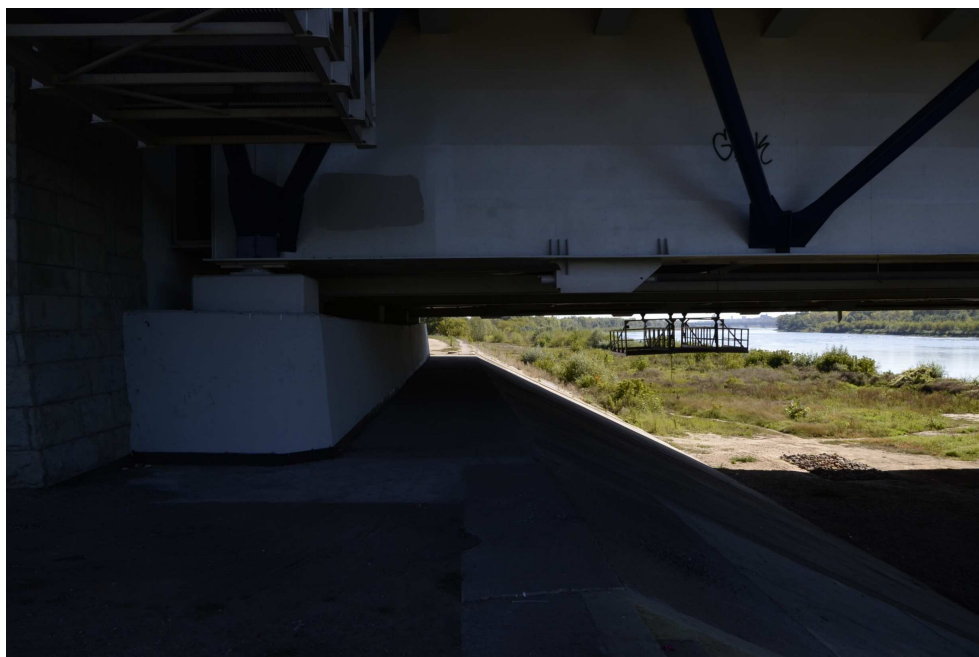
Fot. 12 km 3+170 Przęsło mostu Grota Roweckiego – widok w dół rzeki
