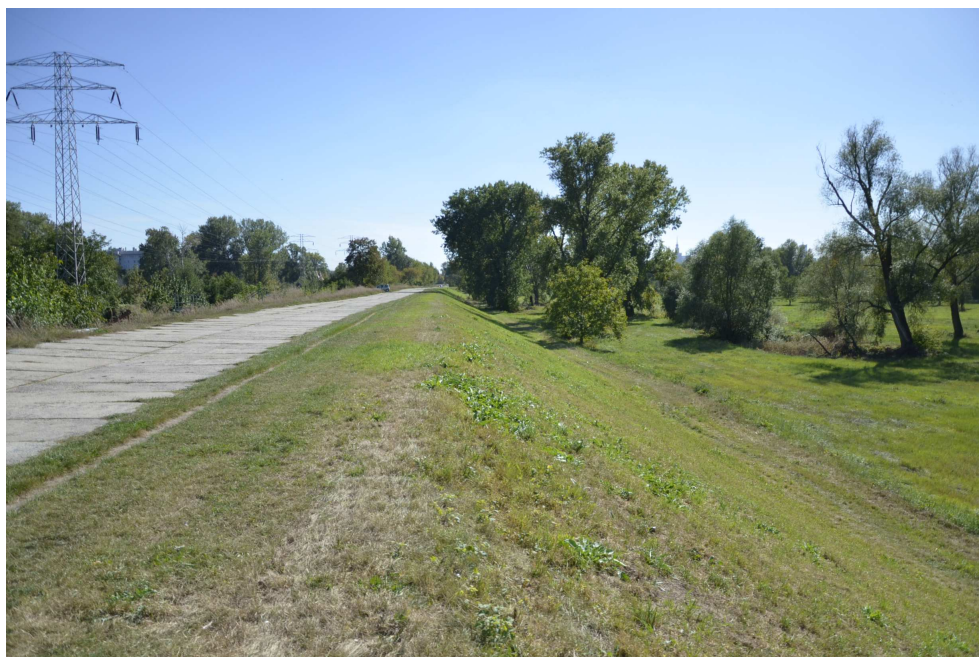
Fot. 6 km 0+810 widok korony i odwodnej skarpy wału
