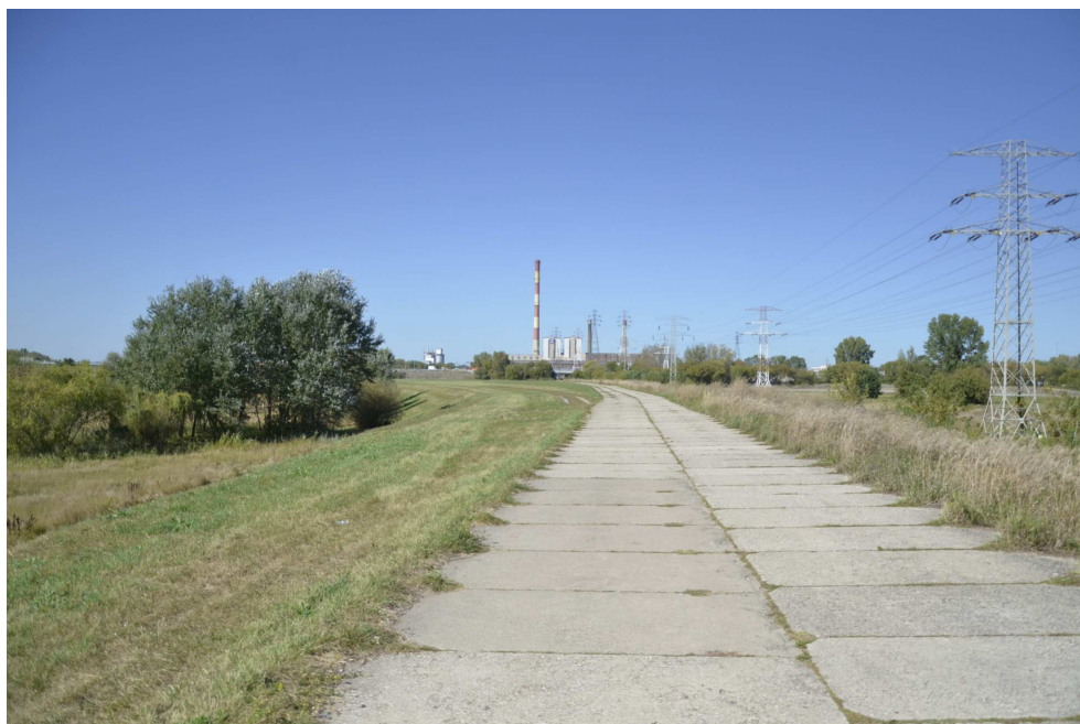
Fot. 10 km 2+500 Korona i skarpa odwodna - widok w dół rzeki
