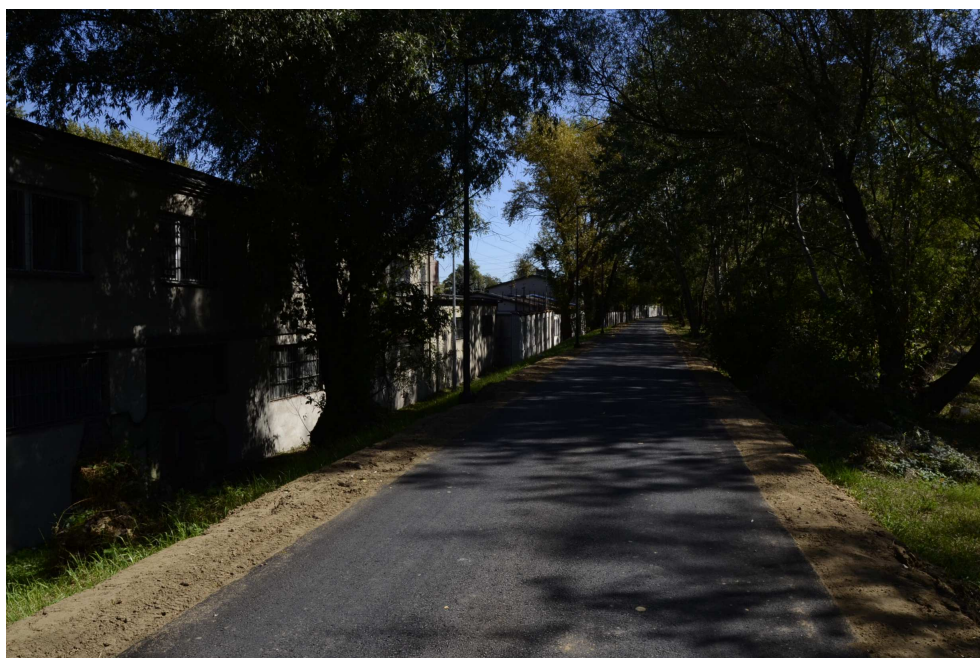
Fot. 14 km 3+700 Korona wału – widok w górę rzeki
