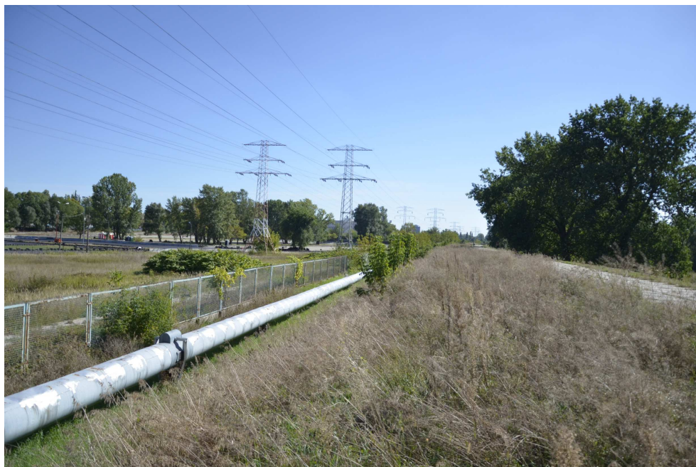
Fot. 9 km 2+050 Skarpa odpowietrzna wału i zawale
