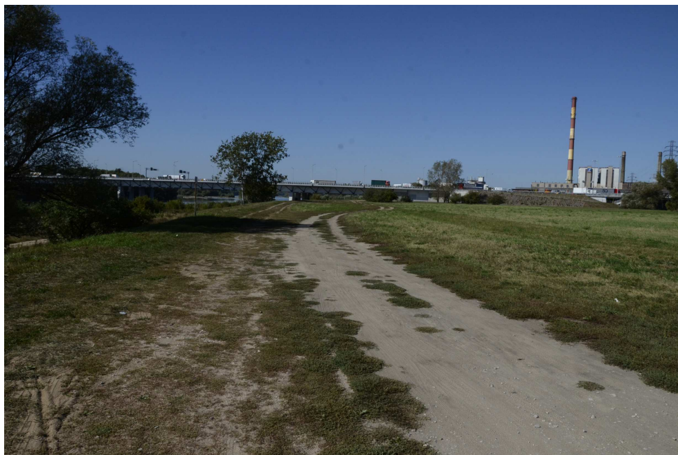
Fot. 11 km 2+840 Oś ewidencyjnego wału - widok w dół rzeki
