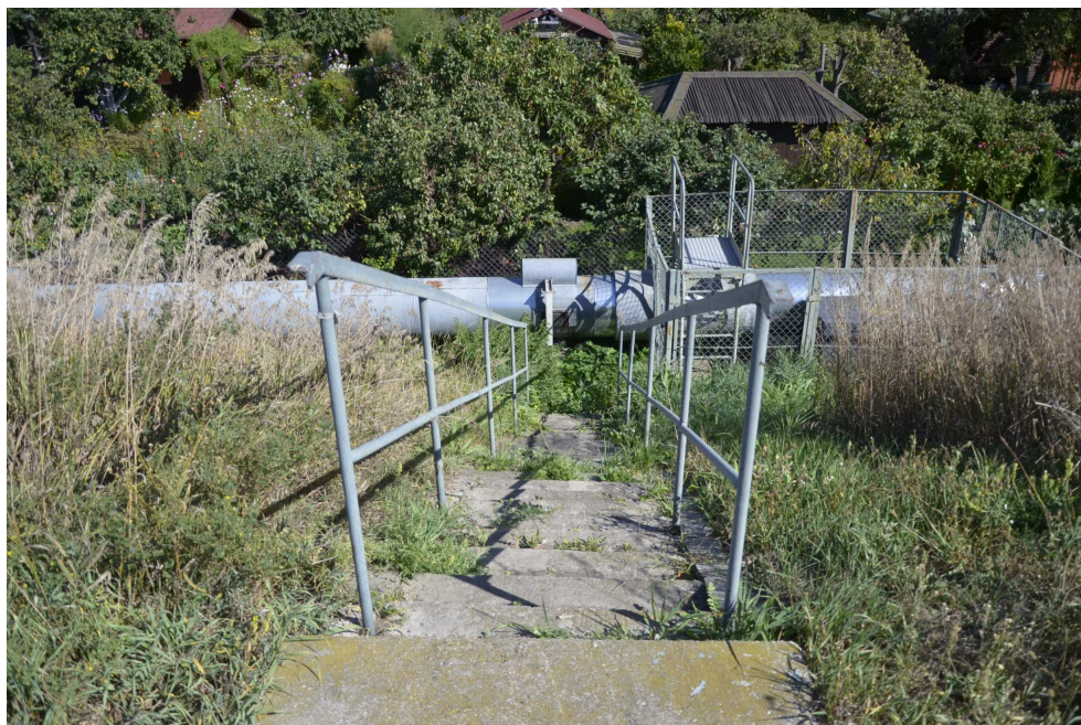
Fot. 7 km 1+282 schody skarpa odpowietrzna
