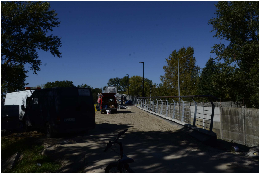
Fot. 17 km 4+380 Wjazd na kładkę
