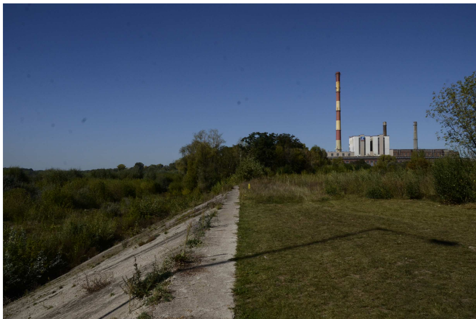
Fot. 13 km 3+200 OŚ ewidencyjnego wału – widok w dół rzeki
