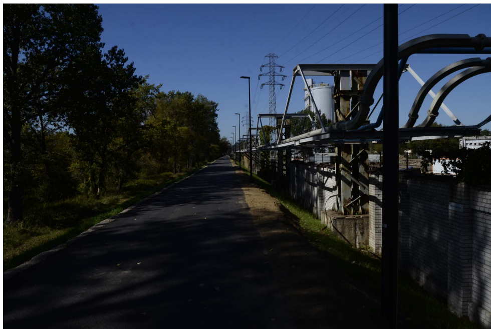
Fot. 15 km 3+900 Korona wału – widok w dół rzeki
